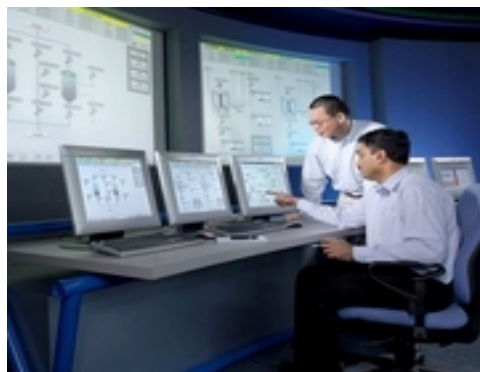
Figura 4.4. Post operator de control a producției
